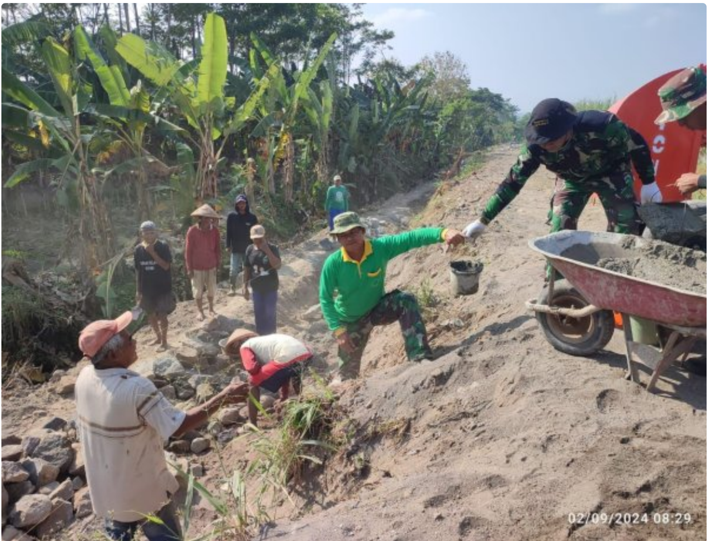
Bangun Talud, Koramil 09 Prambanan Laksanakan KBMKB Ke XXIV Tahun 2024 Di Desa Geneng Klaten
